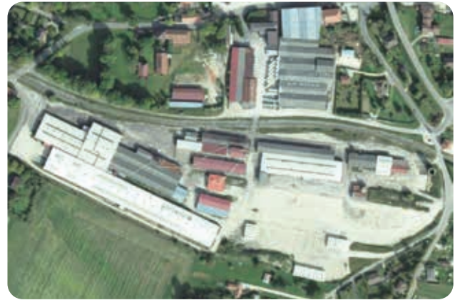
Zone d'activités (zone UX) à Gondrecourt-le-Château
