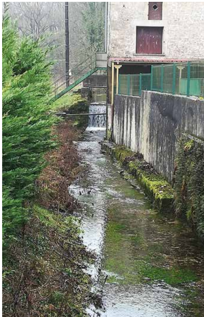
Pour éviter la chute d'eau près de l'ancien moulin, le ruisseau de Montplonne sera détourné sur une centaine de mètres.
