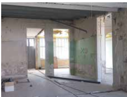
Chantier de la future micro-crèche à Demange-Baudignécourt.
