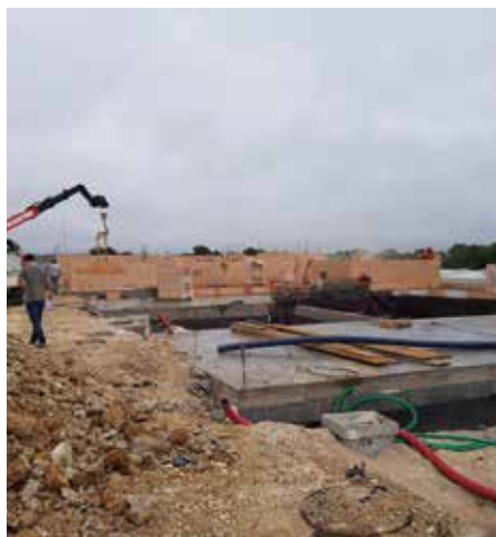
Chantier de la future gendarmerie à Gondrecourt-le-Château.
